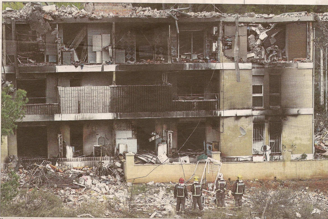
Un grupo de bomberos observa, ayer, el estado en el que quedó el edificio afectado por la explosión. / ANTONIO MORENO
